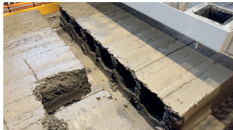
Качество реза по свежему бетону, выполненного с помощью гильотины
