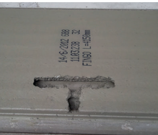
Типичные рабочие отверстия на свежем бетоне
